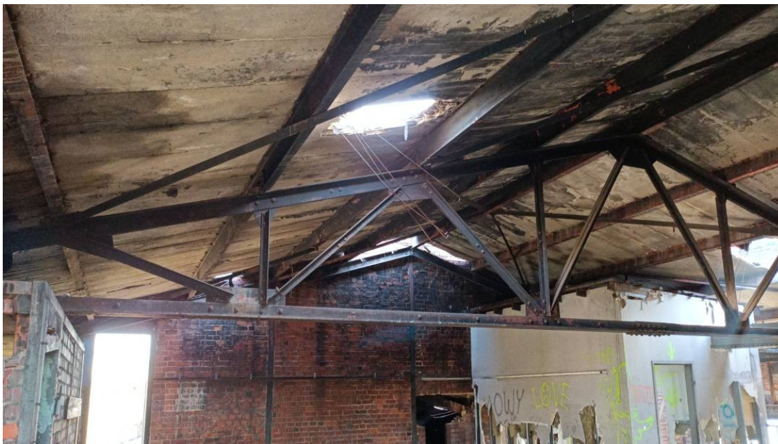
Fot. 35, 36 Dachy części niższej, stan obecny. Zniszczone pokrycie dachu. Uszkodzone płyty dachowe, koryto odpływowe.
