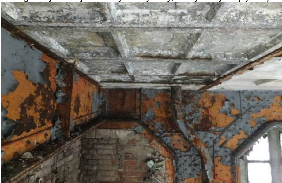
Fot. 49 Poziom stropu 52,35m, Widoczna całkowicie uszkodzona rura spustowa , korozja głównej stalowej konstrukcji nośnej wieży, korozja zbrojenia płyt stropowych.
