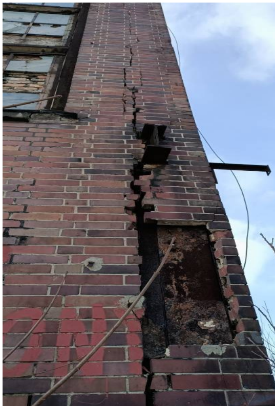
Fot. 43,44 Narożnik północno – wschodni. Uszkodzenie ścian , korozja słupa szkieletu stalowego.
