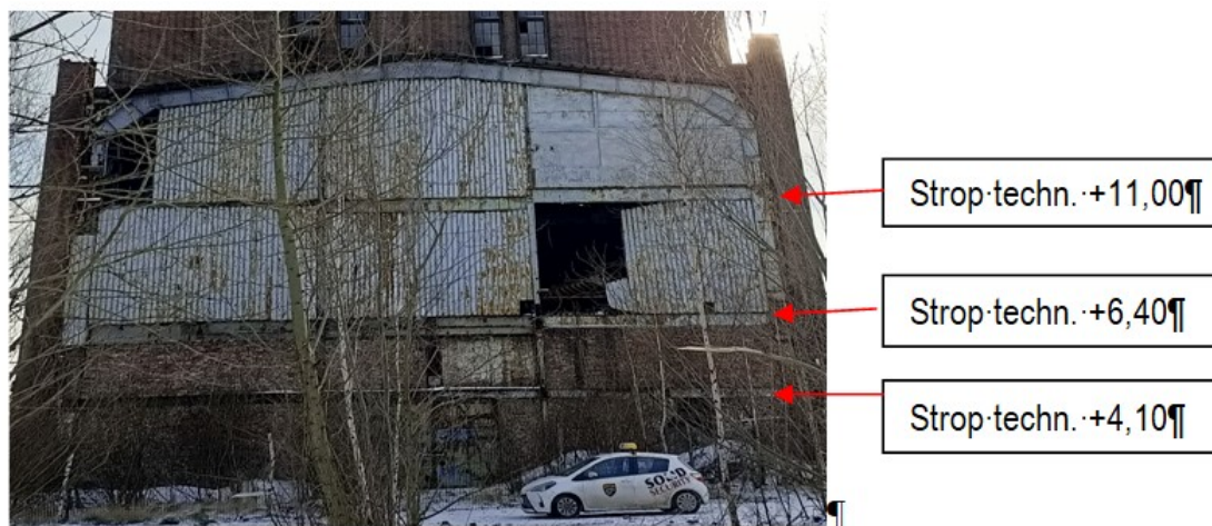
Fot. 10 Część niższa. Rama stalowa w ścianie zewnętrznej , południowej.
