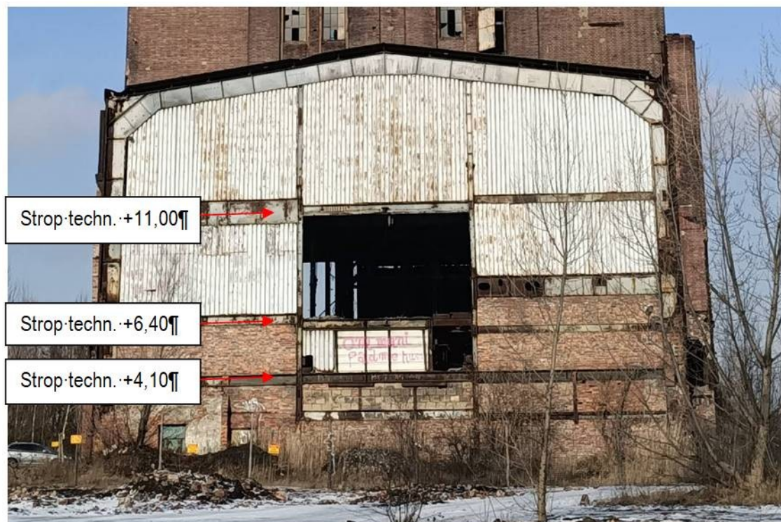
Fot. 10 Część niższa. Rama stalowa w ścianie zewnętrznej , południowej.
