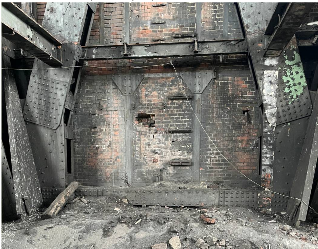
Fot. 13 Poziom \pm 0,00 . Oparcie ram głównych na fundamencie. Ściana zachodnia.
