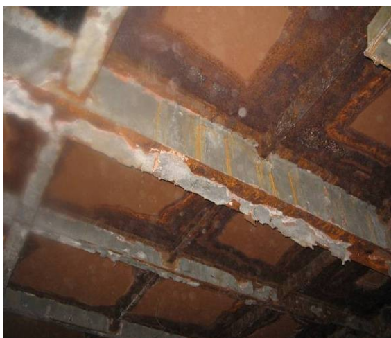
Korozja belek stalowych dolnych stropów technologicznych.
