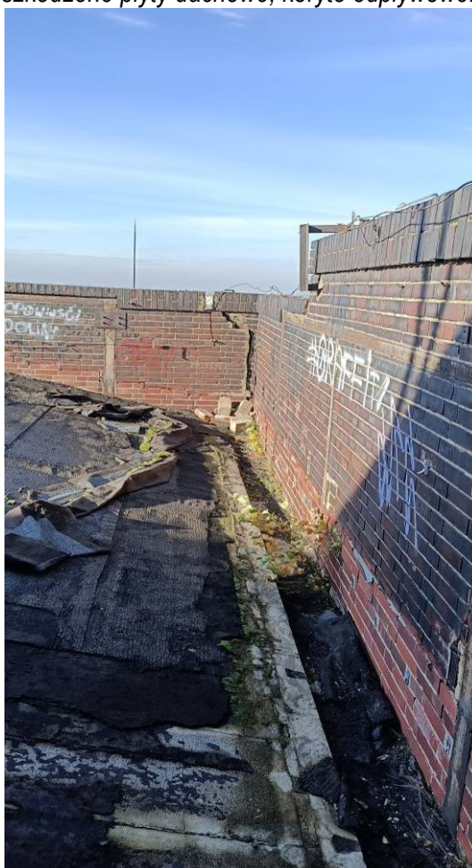
Fot. 35, 36 Dachy części niższej, stan obecny. Zniszczone pokrycie dachu. Uszkodzone płyty dachowe, koryto odpływowe.
